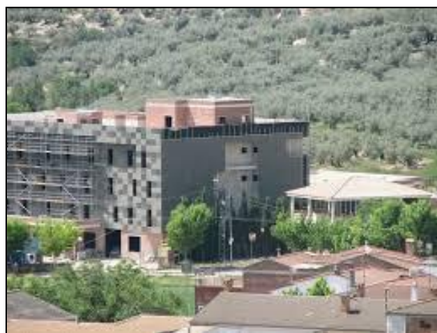
Figura 3. Balneario de Frailes (en construcción).
